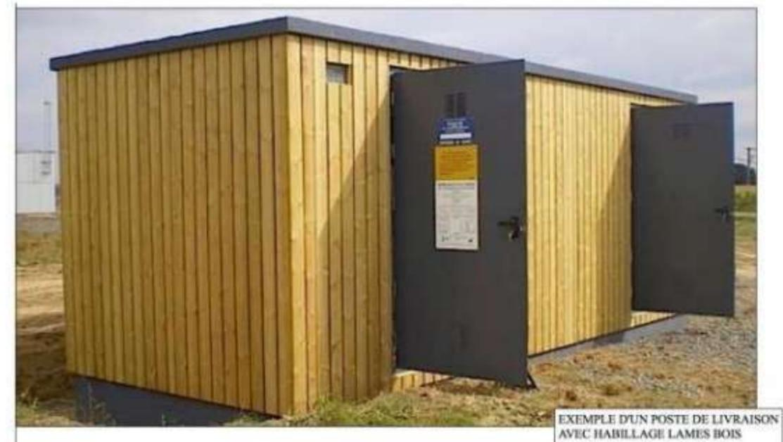
**Illustration 13 : Exemple de module onduleur/poste de transformation**
