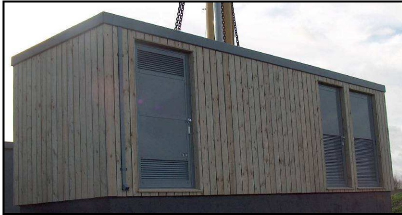
Figure 6 : Exemple de poste de livraison habillé d'un bardage bois (source : VALOREM)
