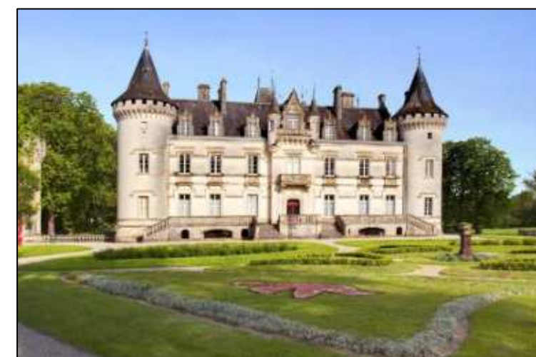
Figure 15 : Photographie du château de Nieuil, à Nieuil (Source : momentum.fr )
