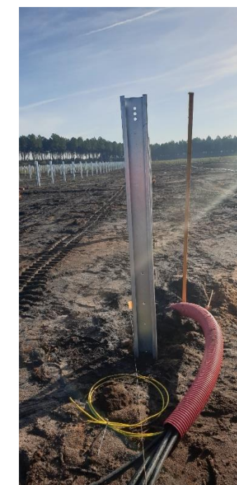
Figure 66 : Illustration d'un pieu battu (Source VALECO)
