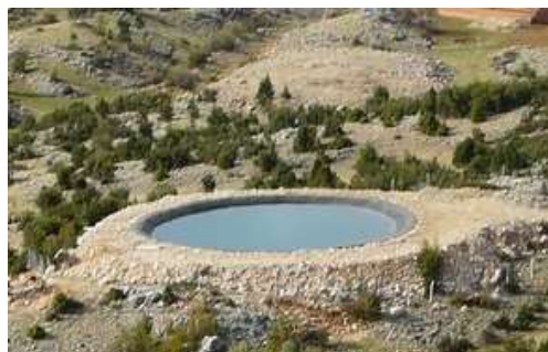
Autre exemple de surface en eau maçonnée
