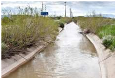
Un fossé maçonné sur le terrain
