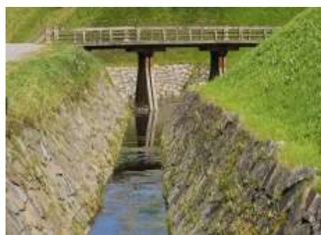
Un fossé maçonné sur le terrain
