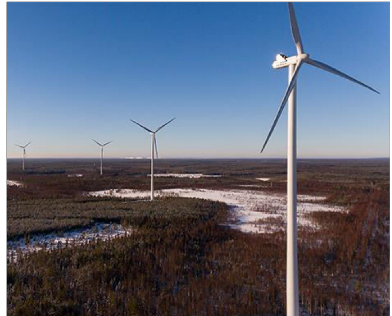
Photographie 3 : Exemple d'éolienne Vestas V150 – 5.6 MW présentant des caractéristiques proches du gabarit envisagé (Source : Vestas)
