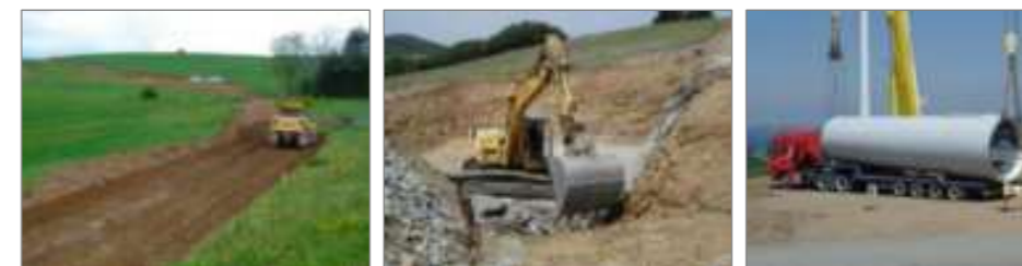
Photographie 61 : Illustration d'un chantier éolien
