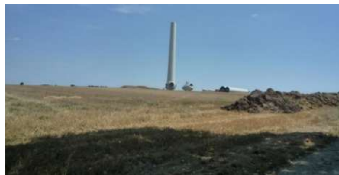
Photographie 58 : Exemple de stockage de terre durant un chantier éolien
