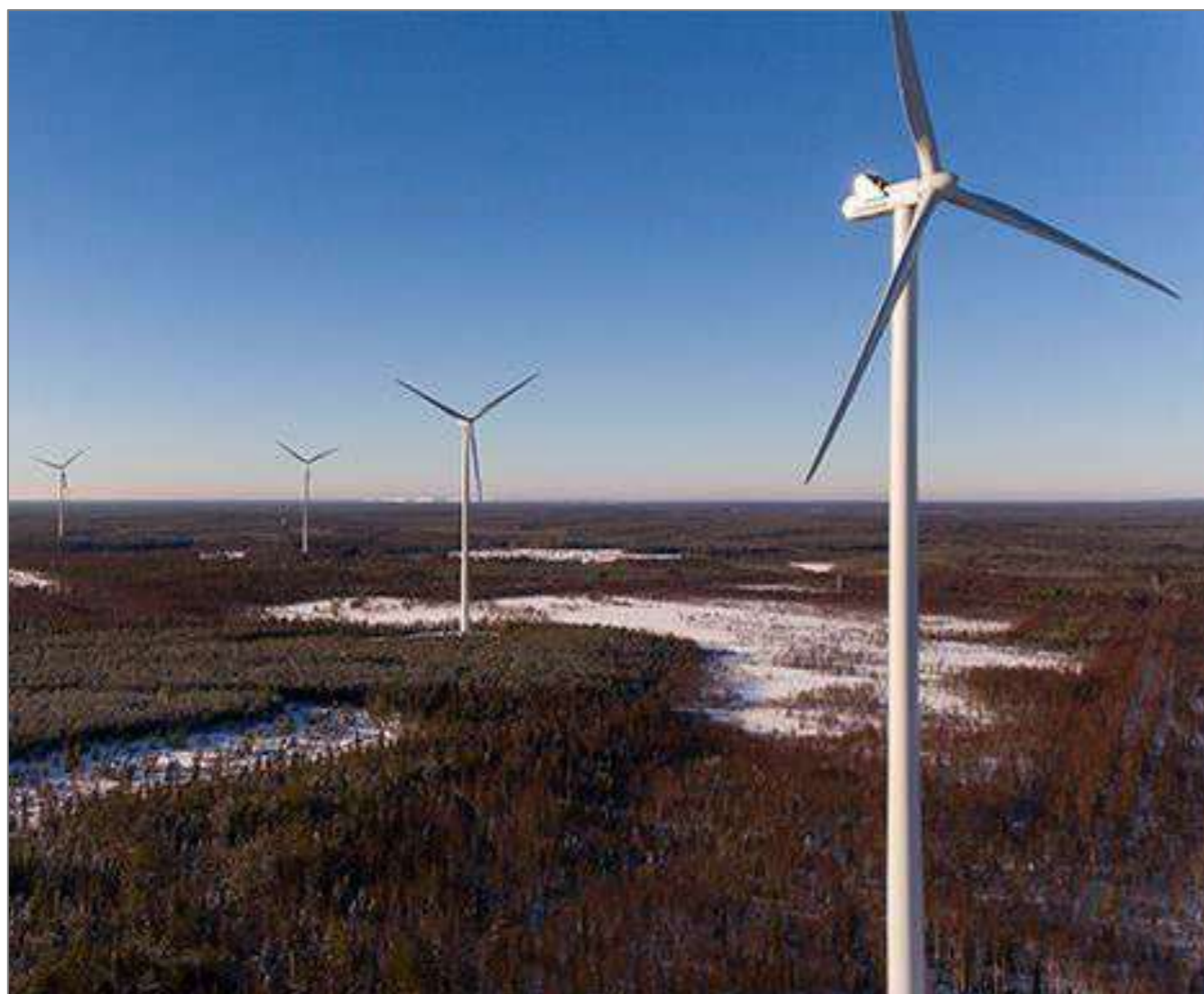
Photographie 50 : Exemple d'éolienne Vestas V150 – 5.6 MW présentant des caractéristiques proches du gabarit envisagé (Source : Vestas)
