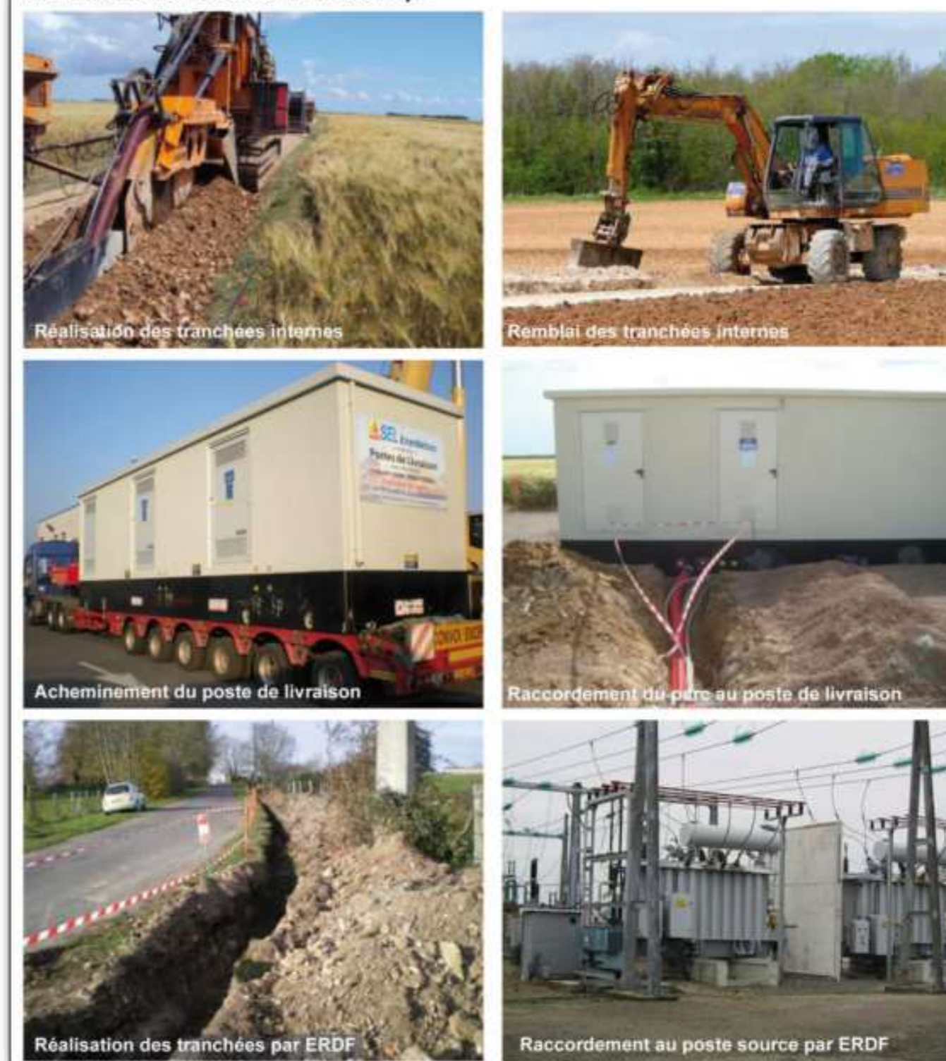
Photographie 55 : Travaux de raccordement électrique
