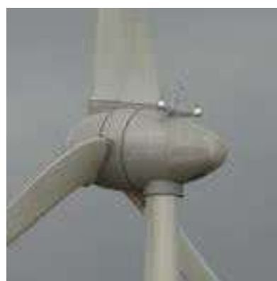
Photographie 62 : exemple de feux de balisage (source : : ENCIS Environnement)
