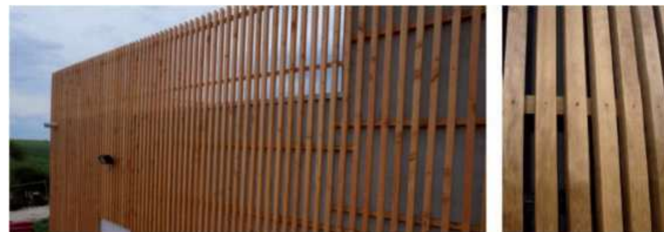
Photographie 51 : Exemple de bardage bois (Source : ENCIS Environnement)
