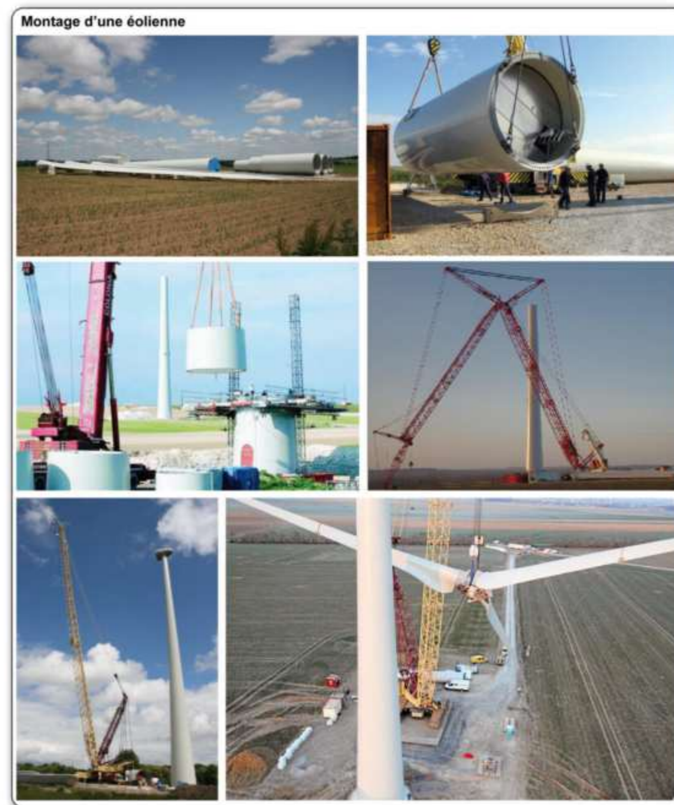
Photographie 56 : Phases d'assemblage d'une éolienne
