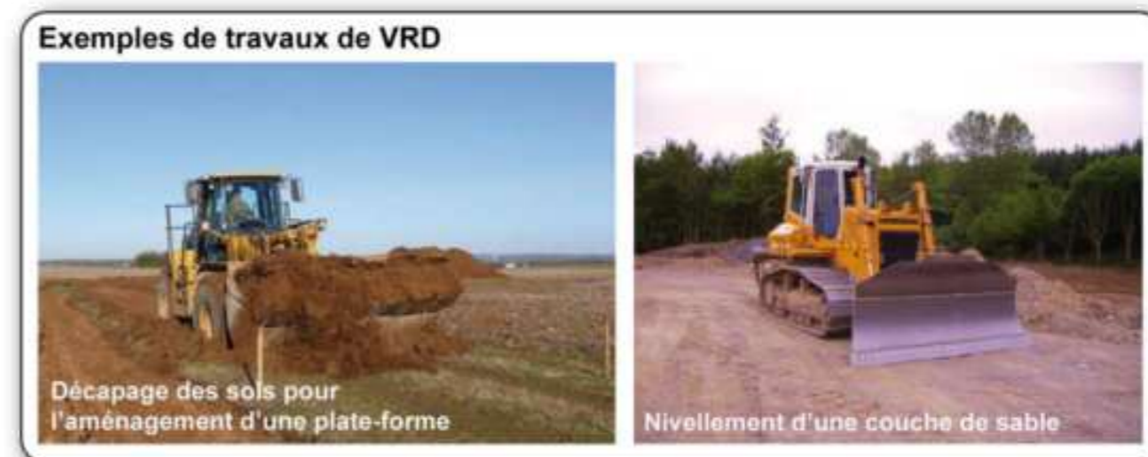
Photographie 53 : Exemples d'engins de travaux de VRD
