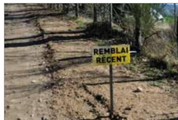
Photographie 59 : Exemple de remblai des tranchées électriques le long d'une piste
