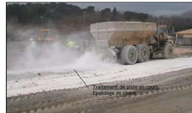
Illustration 13 - Épandage pour traitement à la chaux – piste confectionnée en GNT
