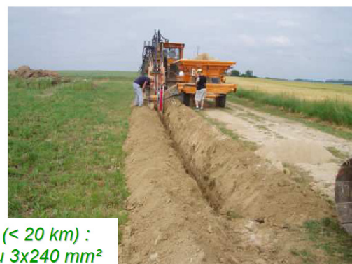
Enfouissement câbles : 0,5 à 1 m de profondeur
