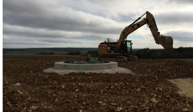
Exemple de fondation en surface
