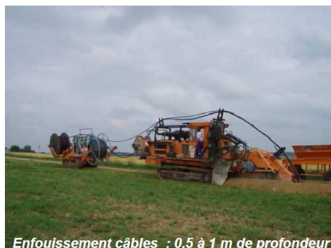
Enfouissement câbles : 0,5 à 1 m de profondeur
