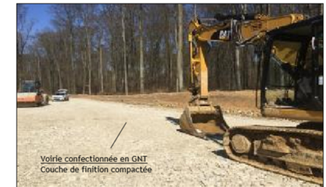
Illustration 13 - Épandage pour traitement à la chaux – piste confectionnée en GNT
