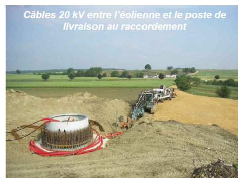
Enfouissement câbles : 0,5 à 1 m de profondeur
