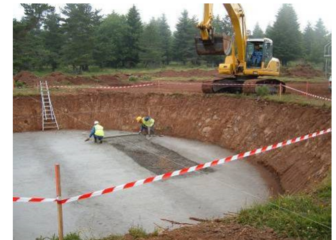
Illustration 4 : Béton de propreté
