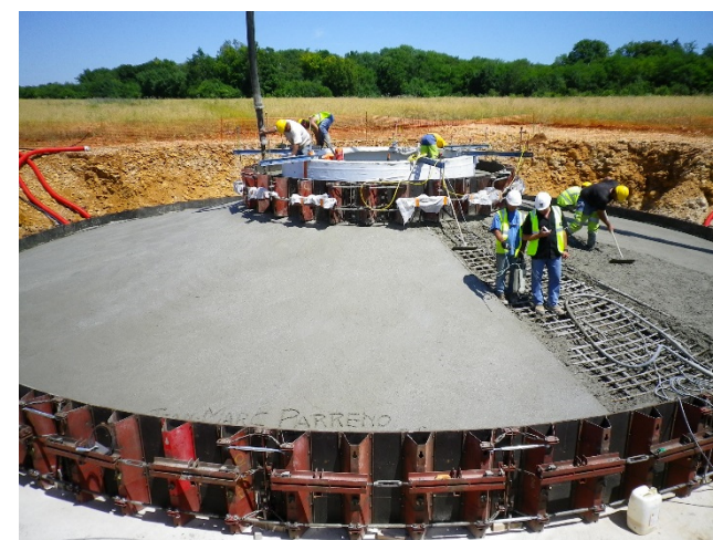
Illustration 8 : Coulage et lissage du béton
