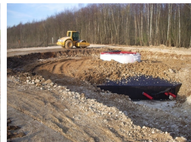
Illustration 10 : Remblayage et compactage autour de la fondation
