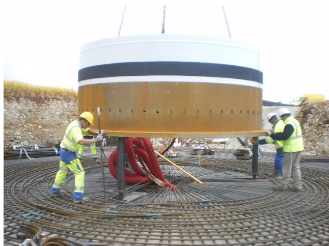
Illustration 5 : Insert « support » de l'éolienne
