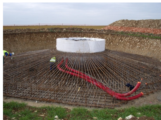
Illustration 6 : Ferrailage autour de la bride d'ancrage
