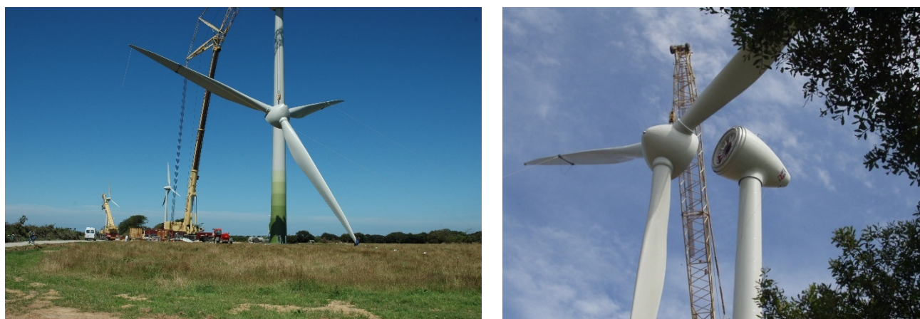
Illustration 13 : Assemblage et hissage de la nacelle, du moyeu et des pales
