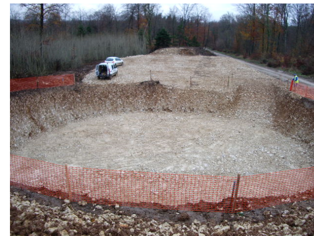
Illustration 3 : Fond de fouille après décapage et terrassement
