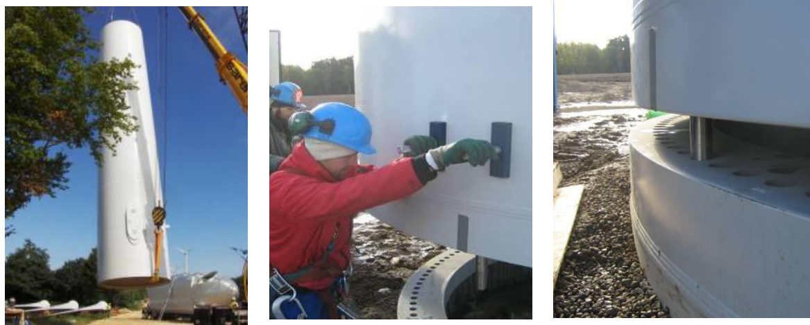
Illustration 12 : Assemblage et hissage de la tour
