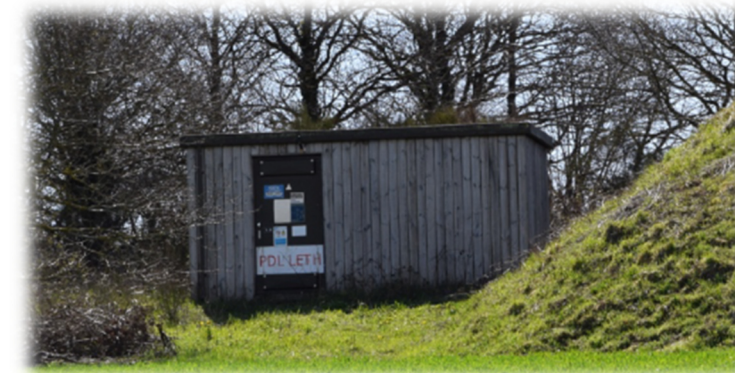
Illustration 14 : Intégration d'un poste de livraison dans l'environnement du projet
