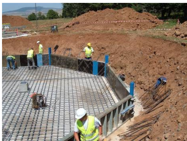
Illustration 7 : Coffrage pour le coulage du béton
