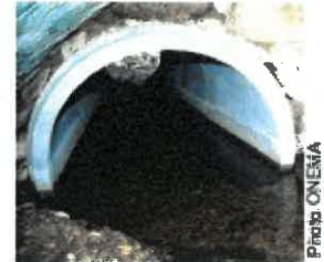
Ouvrage de franchissement bien calé
