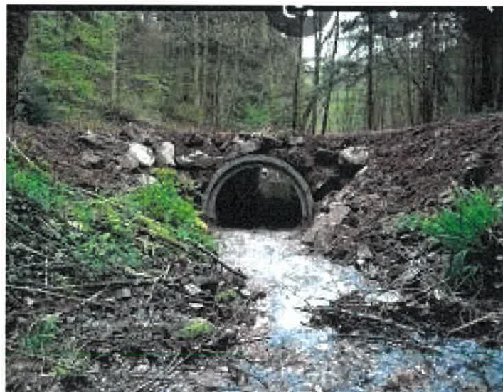
Ouvrage de franchissement posé selon la réglementation en vigueur
