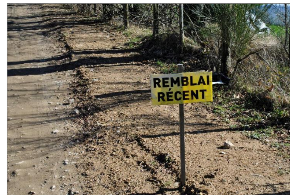
Photographie 34 : Exemple de remblai des tranchées électriques le long d'une piste (Source : ENCIS Environnement)
