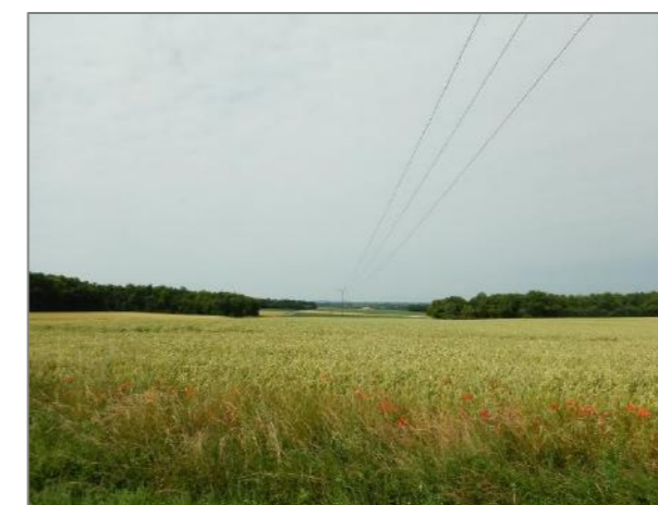
Photographie 10 : Ligne HTA au sud de la ZIP (Source : ENCIS Environnement)
