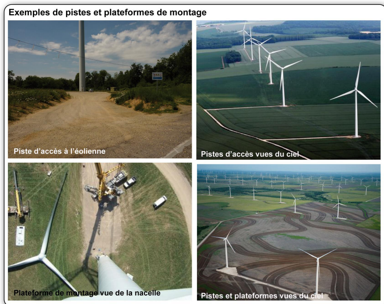
Photographie 27 : Exemples de plateformes de montage et de pistes
