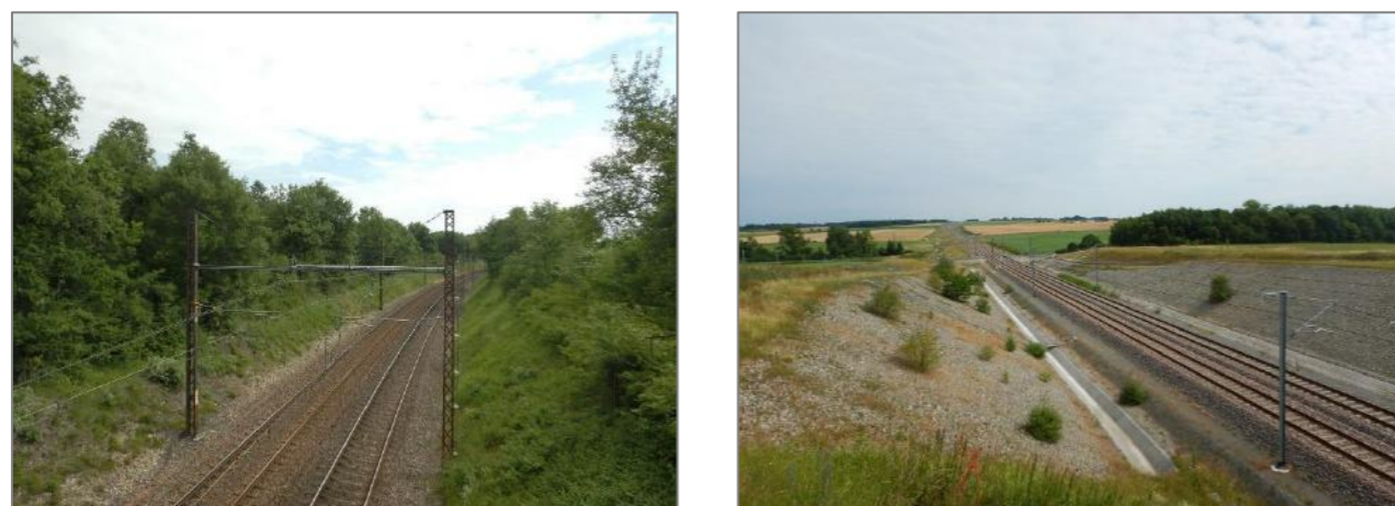
Photographie 12 : Ligne TER - à droite - et LGV - à gauche (Source : ENCIS Environnement)
