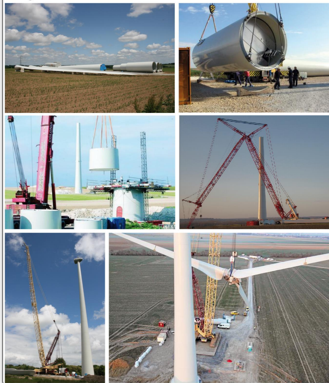
Montage d'une éolienne
