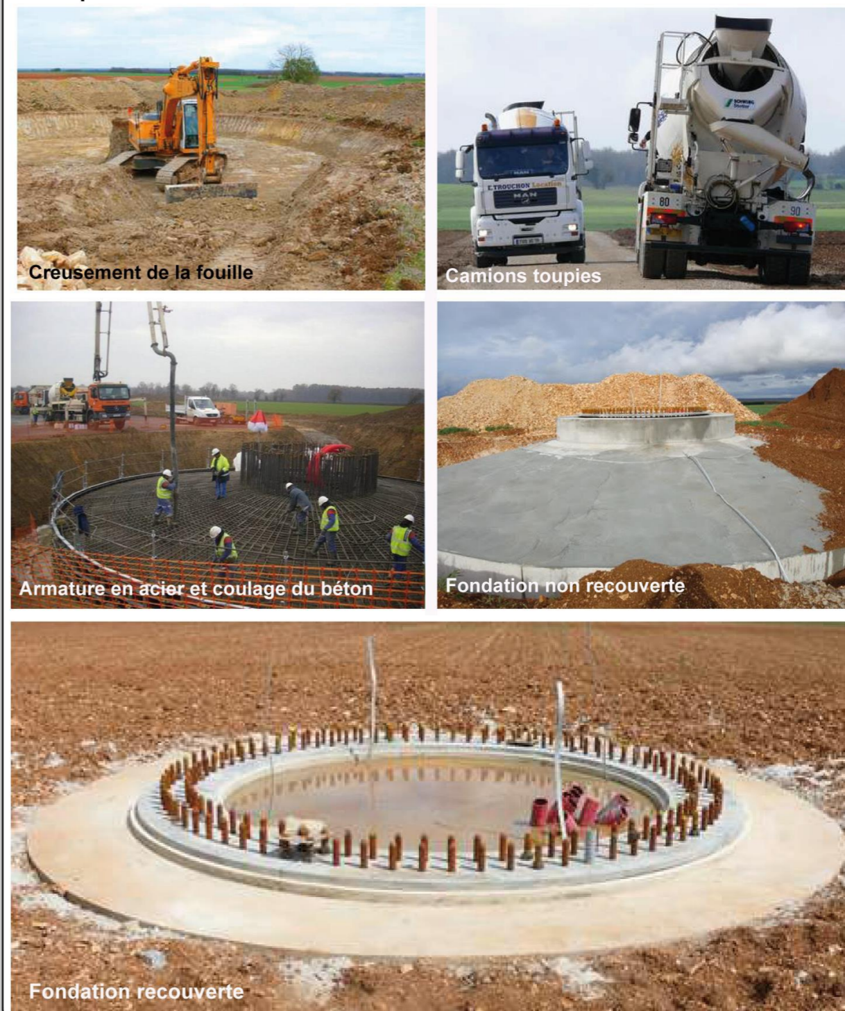
Photographie 30 : Etapes de réalisation d'une fondation d'éolienne
