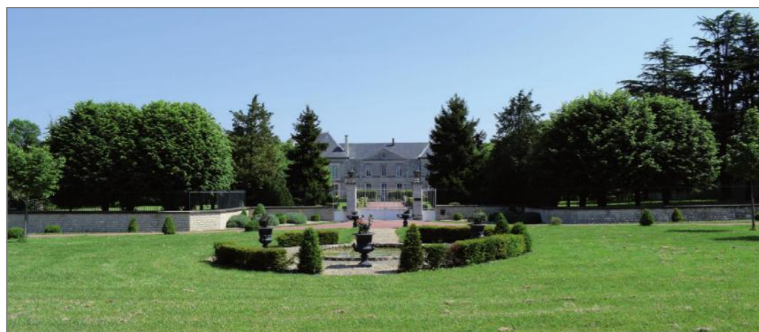
Photographie 22 : Façade sud-ouest du Château des Plans (Source : ENCIS Environnement)
