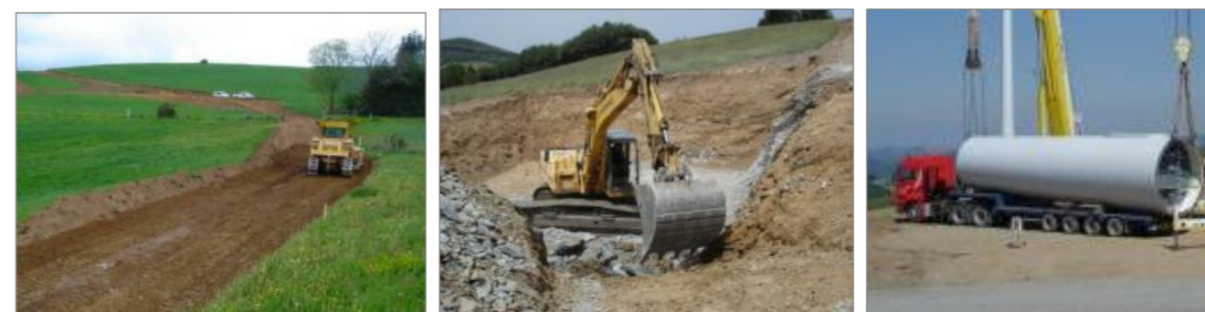
Photographie 36 : Illustration d'un chantier éolien
