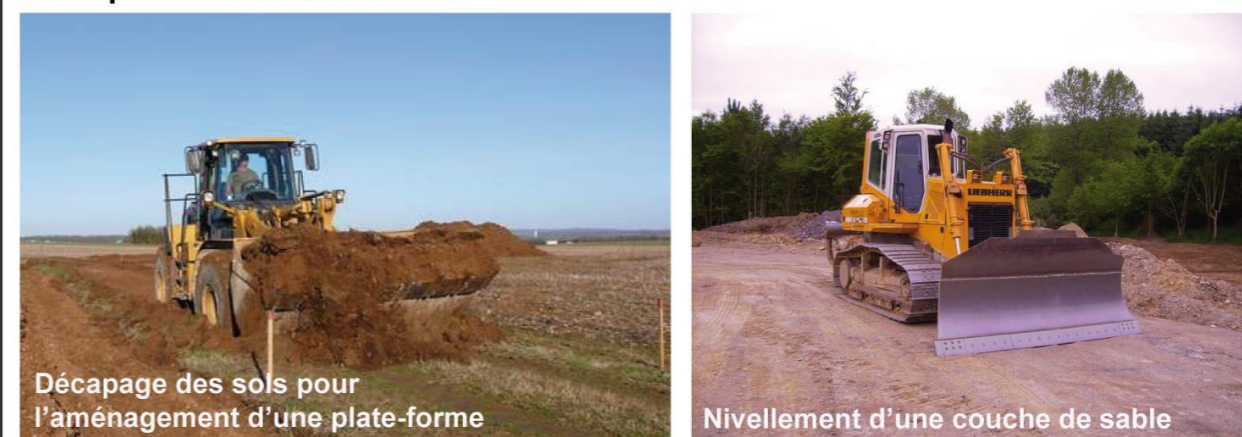
Photographie 29 : Exemples d'engins de travaux de VRD
