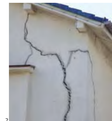
1- La végétation peut avoir un effet aggravant sur les sols argileux car ils pompent l'eau contenue dans le sous-sol.
