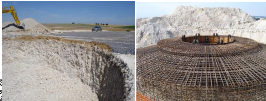
Figure 130 : Construction des fondations des éoliennes
