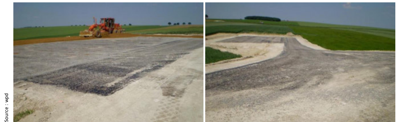
Figure 129 : Aménagement des plateformes de grutage
