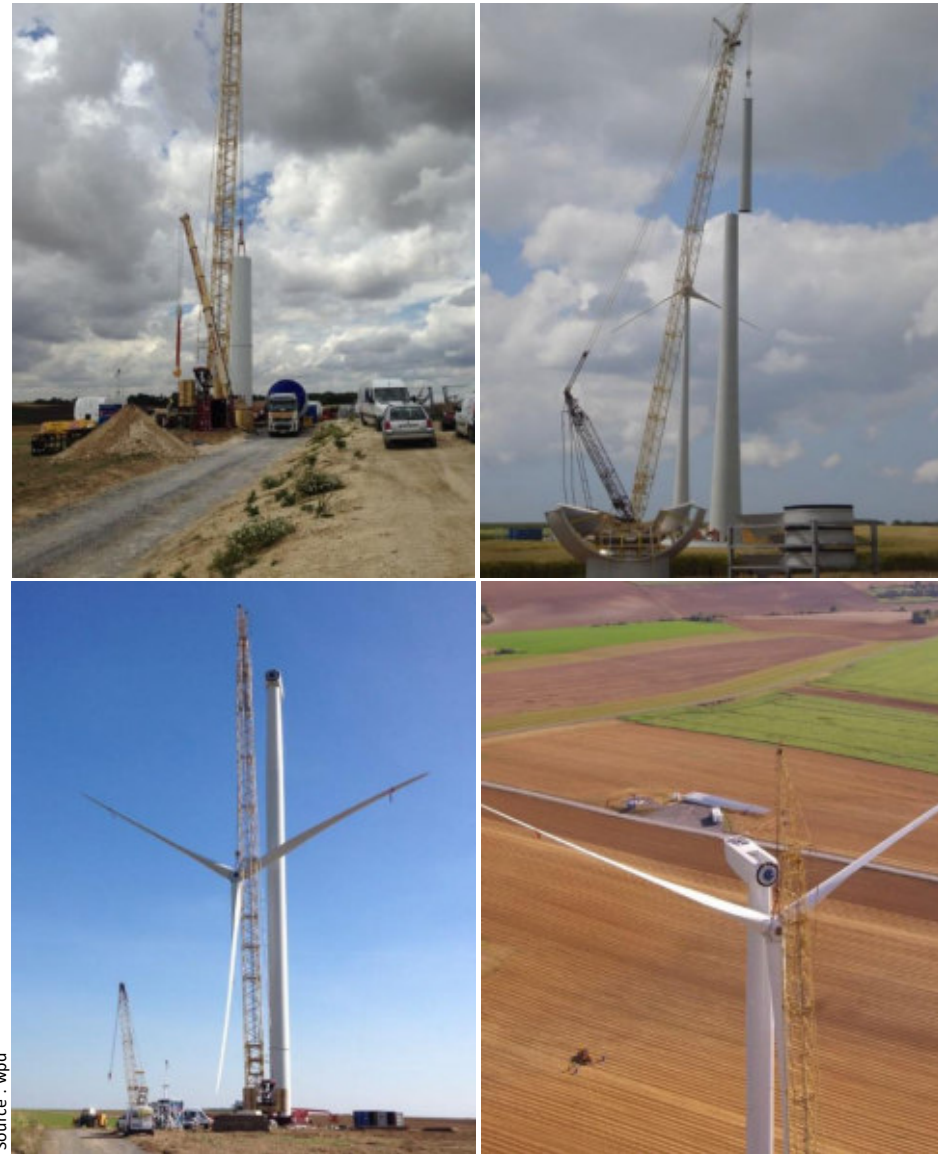
Figure 132 : Montage du mât et levage du rotor
