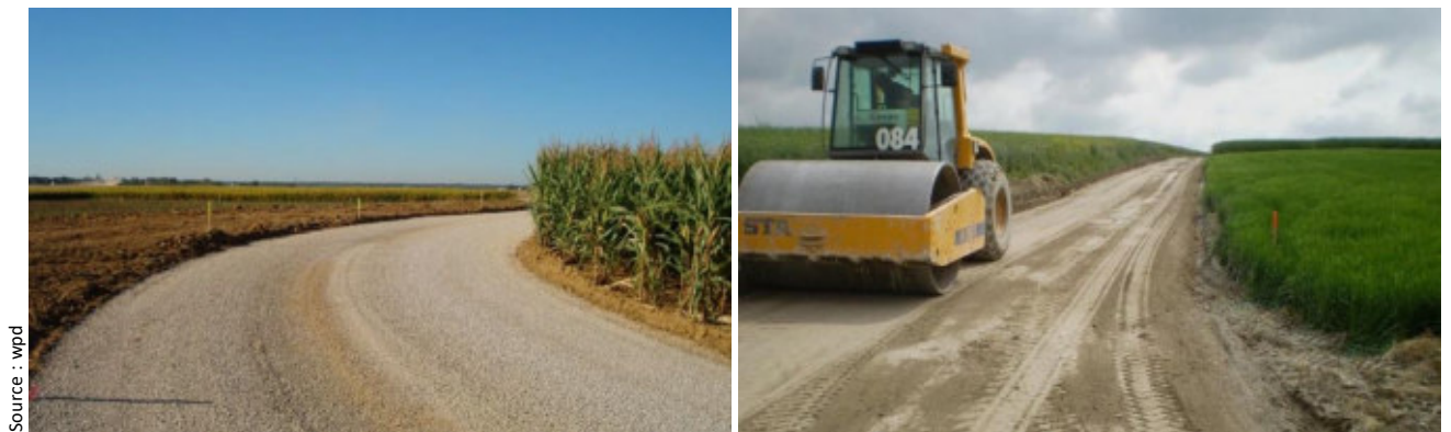
Figure 128 : Aménagement des chemins d'accès du parc éolien
