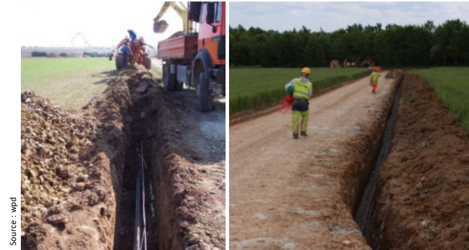
Figure 133 : Travaux de raccordement électrique
