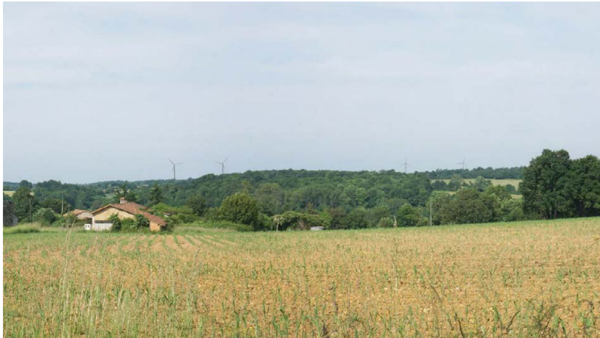
SIMULATION DU PROJET - VUE COUPÉE À 45° (VUE RESTITUANT LA VISION HUMAINE). POUR UNE OBSERVATION RÉALISTE, PLACER LES YEUX À ENVIRON 35 CM DE LA PAGE.
