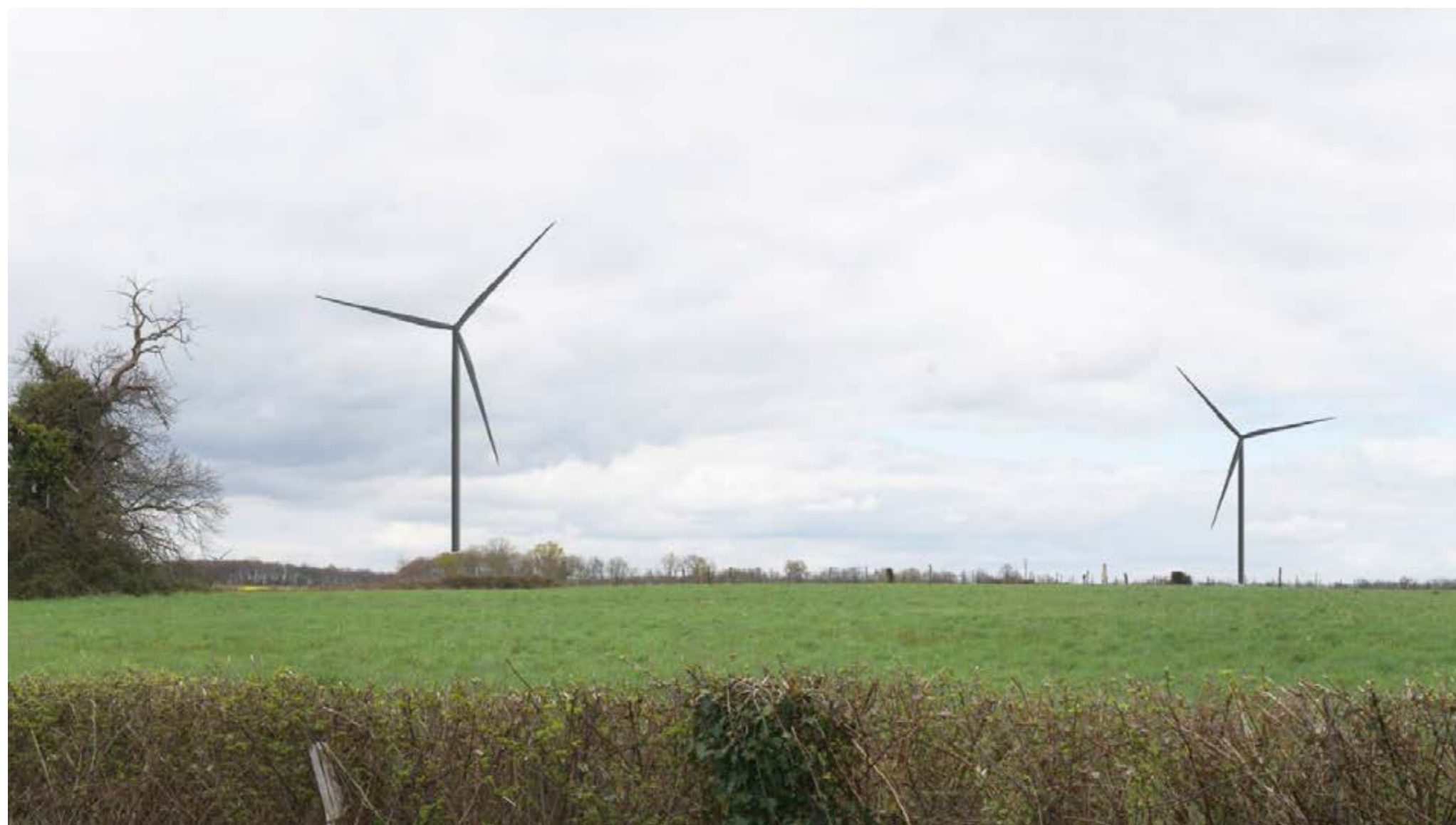
SIMULATION DU PROJET - VUE COUPÉE À 45° (VUE RESTITUANT LA VISION HUMAINE). POUR UNE OBSERVATION RÉALISTE, PLACER LES YEUX À ENVIRON 35 CM DE LA PAGE.
