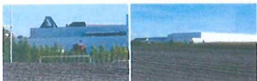
Dégradation des vues en venant du Sud
