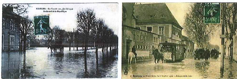
Figures 4 et 5 – Inondation du boulevard de la République et de l'avenue de la Gare à Bourges le 22/01/1910 (AM Bourges)
