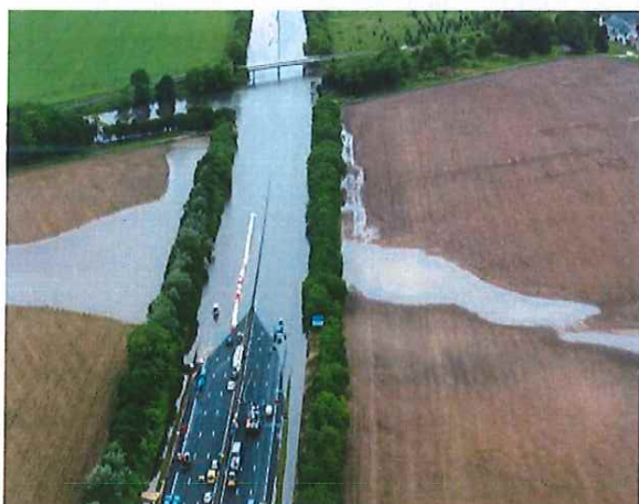
Figure 9 - Inondation de l'autoroute A10 en mai-juin 2016 au nord d'Orléans par la Retrève
