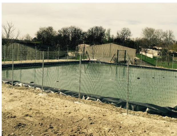
Figure 1 Bassin de réserve d'eau incendie de 750 m 3
