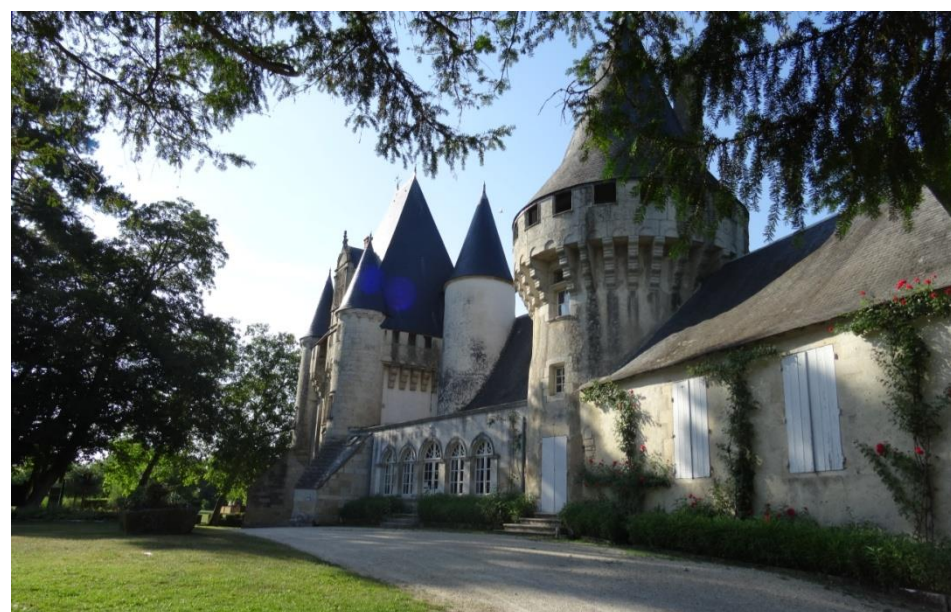
Photographie 36 – Château de Javarzay à Chef-Boutonne (MH.41) (Source : ECO-STRATEGIE, le 6 juillet 2015)
