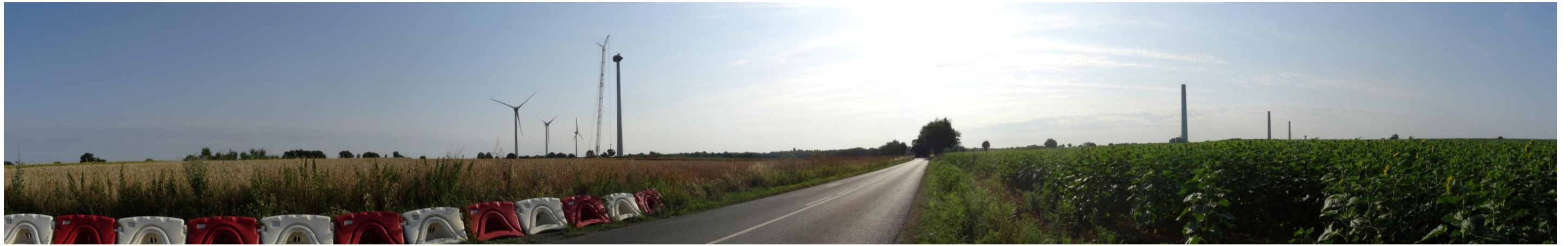
Photographie 1 – Parc éolien MLHCP en construction le long de la RD 1 au sein de l'aire d'étude intermédiaire (Source : ECO-STRATEGIE, le 7 juillet 2015)
