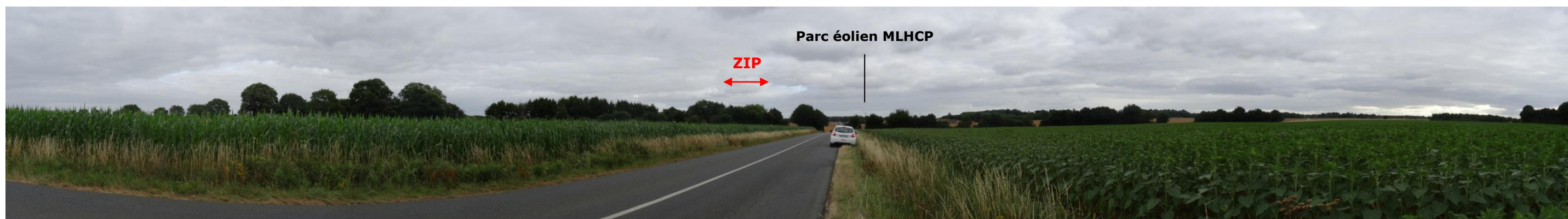
Photographie 83 – Vue incluant la ZIP depuis la RD 45 à Clussais-la-Pommeraiie et visibilité sur le parc éolien en construction MLHCP (Source : ECO-STRATEGIE, le 8 juillet 2015)
