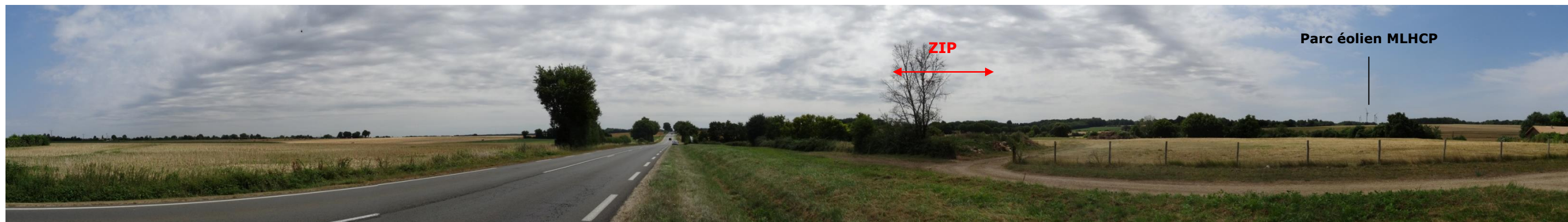
Photographie 82 – Vue incluant la ZIP depuis la RD 948 à l'ouest de Saucé-Vaussais et visibilité sur le parc éolien en construction MLHCP (Source : ECO-STRATEGIE, le 7 juillet 2015)
