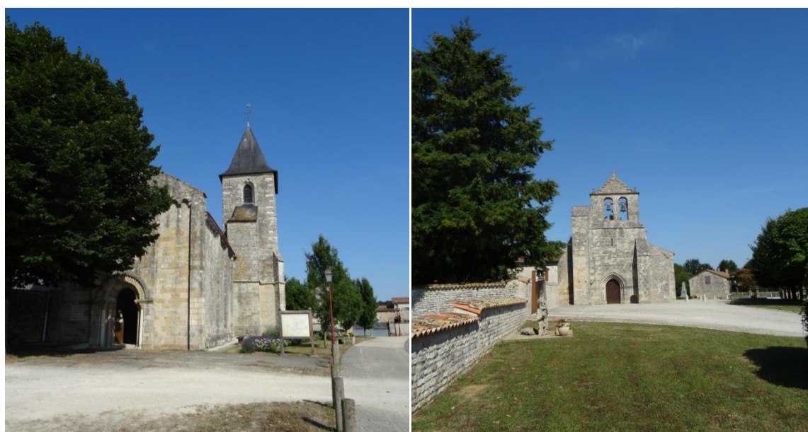
Photographies 24 et 25 – Église de Bouin (MH.38) à gauche et de Pioussay (MH.52) à droite (Source : ECO-STRATEGIE, le 6 juillet 2015)
