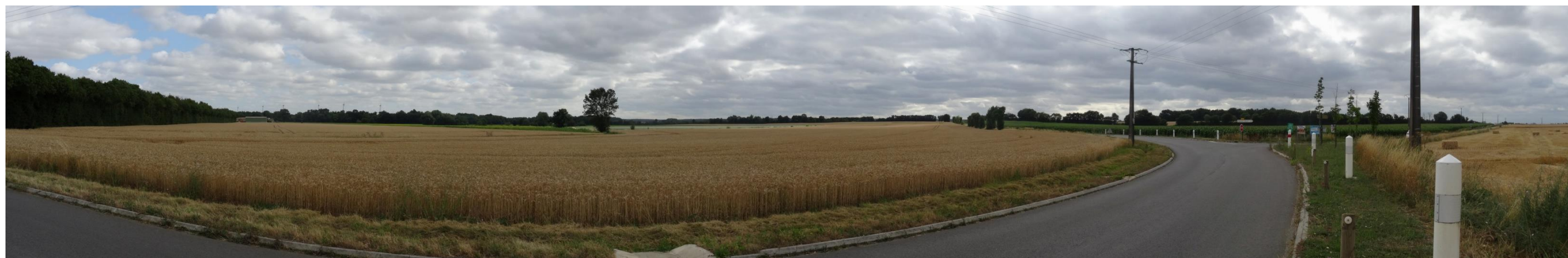
Photographie 67 – Vue depuis la RD 9 au croisement avec la RD 61 à Paizay-Naudoin-Embourie et vue sur le parc éolien MLHCP en construction (Source : ECO-STRATEGIE, le 7 juillet 2015)
