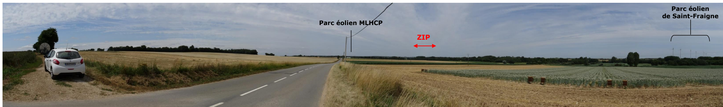
Photographie 73 – Vue incluant la ZIP depuis la RD 737 au sud de Longré à proximité du Vivier – Visibilité des parcs éoliens MLHCP en construction et St-Fraigne (Source : ECO-STRATEGIE, le 7 juillet 2015)
