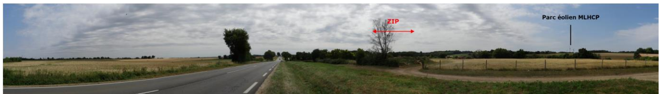
Figure 70 : Vue incluant la ZIP depuis la RD 948 à l'ouest de Sauzé-Vaussais et visibilité sur le parc éolien en construction MLHCP [Source : ECOSTRATEGIE, le 7 juillet 2015]
