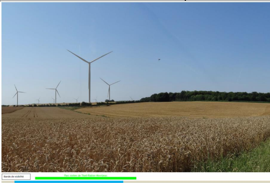
Figure 116 : Photomontage 60° depuis une route secondaire au sud-ouest du hameau de la Grande Neuve à Montjean
